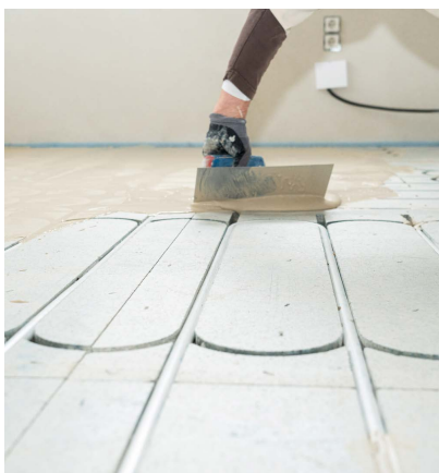
Variante 2 : recouvrement des tubes par un enduit de ragréage
