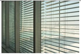
La lamelle Windra allie une élégance filigrane à une stabilité exceptionnelle et assure un guidage flexible de la lumière du jour ainsi qu'une protection thermique fiable, même en cas de forte exposition au vent.
