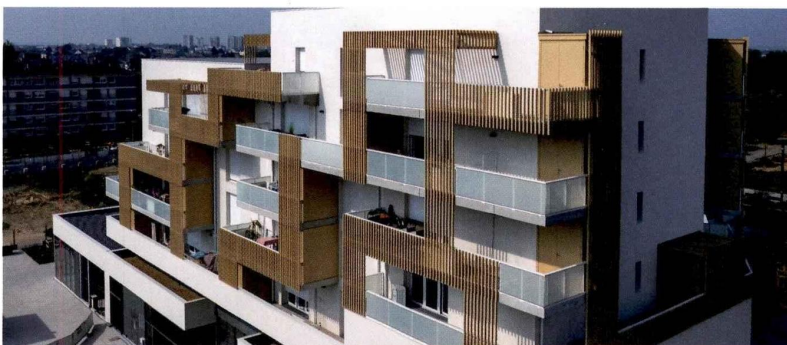
Cadiou : Angers - Place de l'Europe- îlot Nord. 60 appartements sur 6 étages. 600 ml de garde-corps (modèle Klair vitré, pose sur dalle et Ekrit barreaudé pose sur dalle) - Co-maîtrise d'ouvrage : Angers Loire Habitat et SCCY commerces de Montplaisir- Architecte Lionel Vie & Associés
